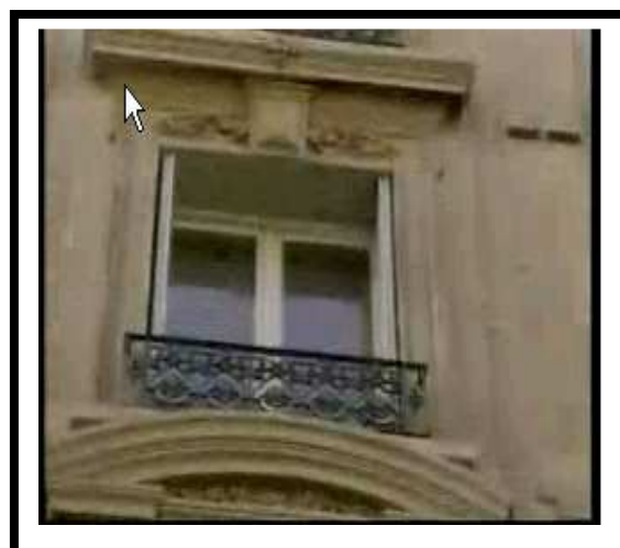
Figura 11 - Janela da fachada do prédio onde habitam Benoît e Julie.
