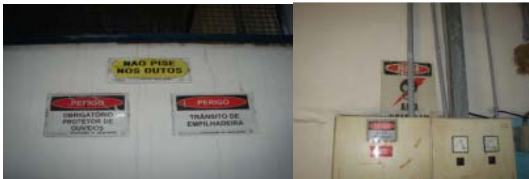
Exemplo 4 - Placas de instrução de segurança afixadas na área de fabricação de dutos
